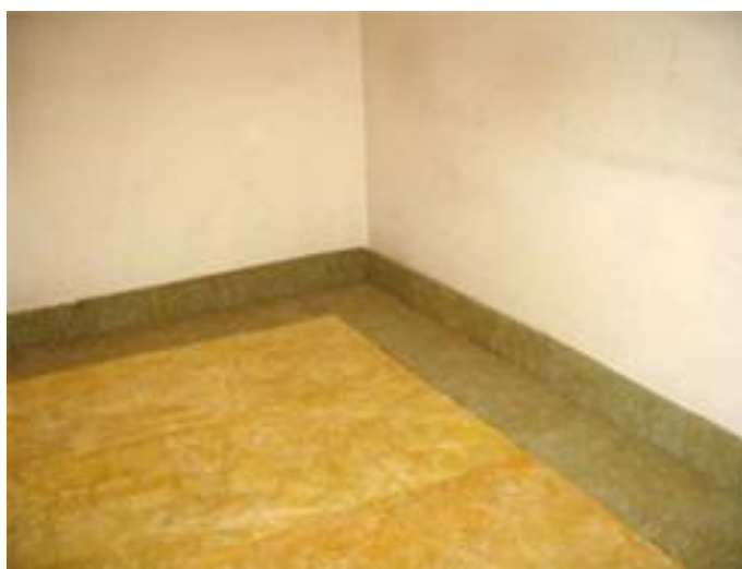
Рисунок 5. Фото раскладки плит Шумостоп
